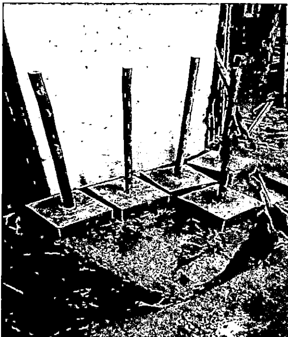
VISTA N° 26: CONSTRUCCION DE PARANTES PARA SEÑALIZACION DE LA OBRA
