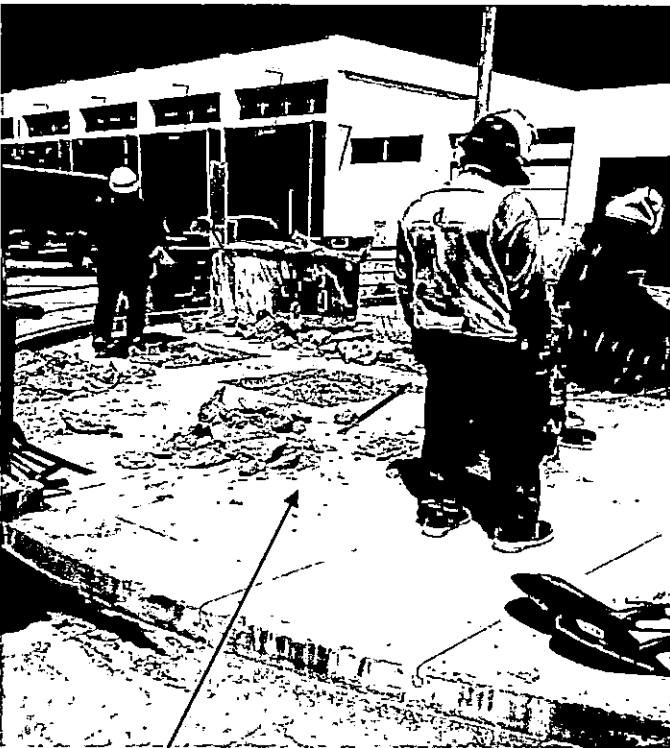
VISTA N° 66: DEMOLICION LOSA DE CONCRETO EN AREA DE LA SAB.- DPA.
