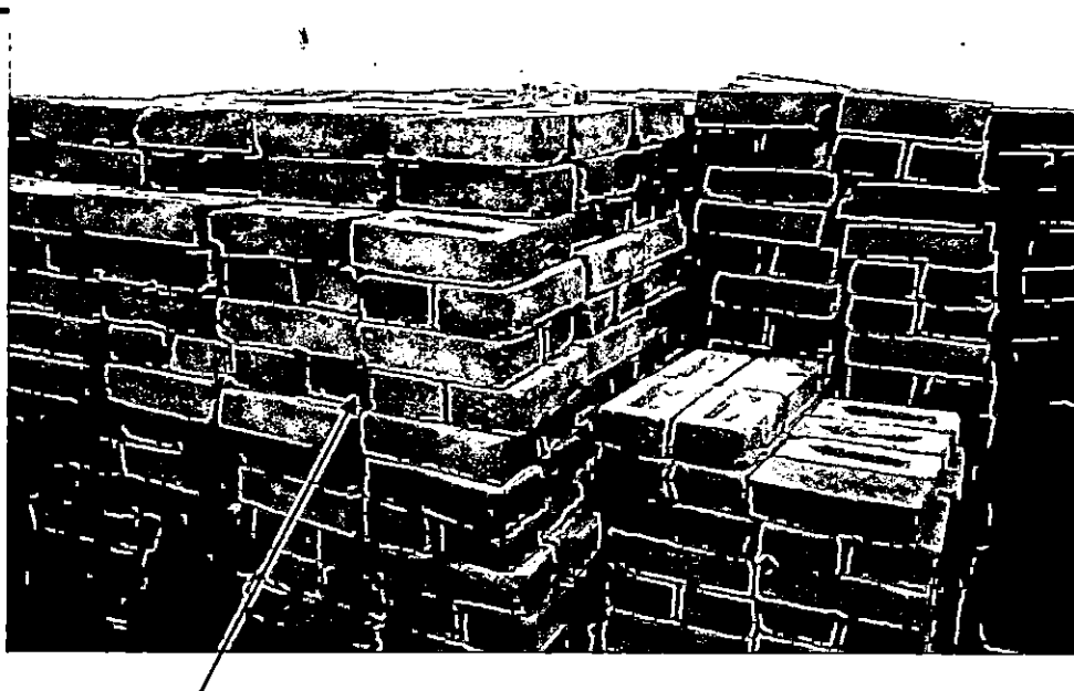
VISTA N° 75: INGRESO ALMACEN LADRILLOS PARA LA OBRA
