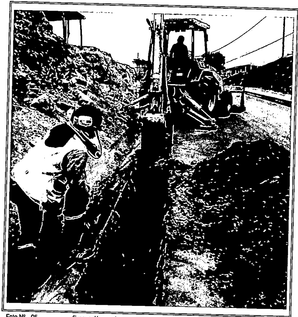
Excavación con la maquinaria en el tramo de la pista de ingreso al DPA.
