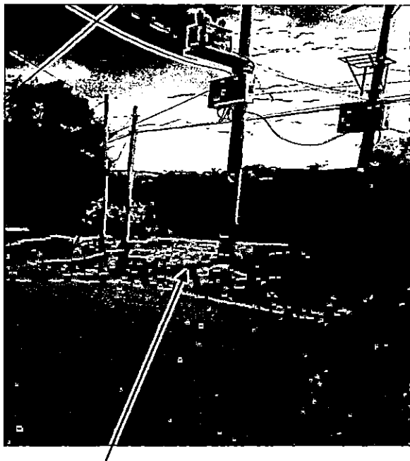
VISTA N° 03: ESTRUCTURA PUNTO DE DISEÑO – RED AEREA 10KV.
