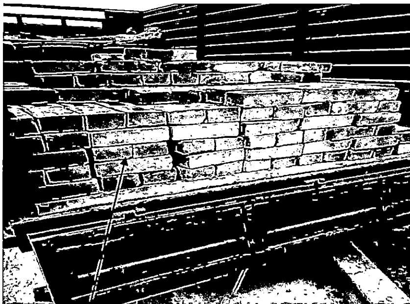
VISTA N° 74: INGRESO ALMACEN LADRILLOS PARA LA OBRA .
