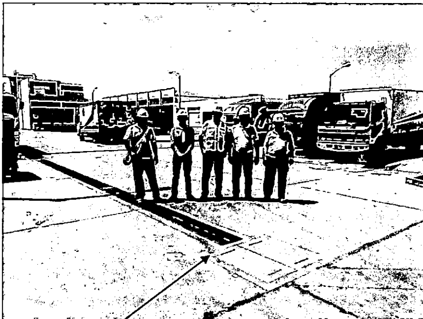
VISTA N° 11: TRAMO RED SUBTERRANEA B.T.- AREA INTERIOR DEL DPA.
