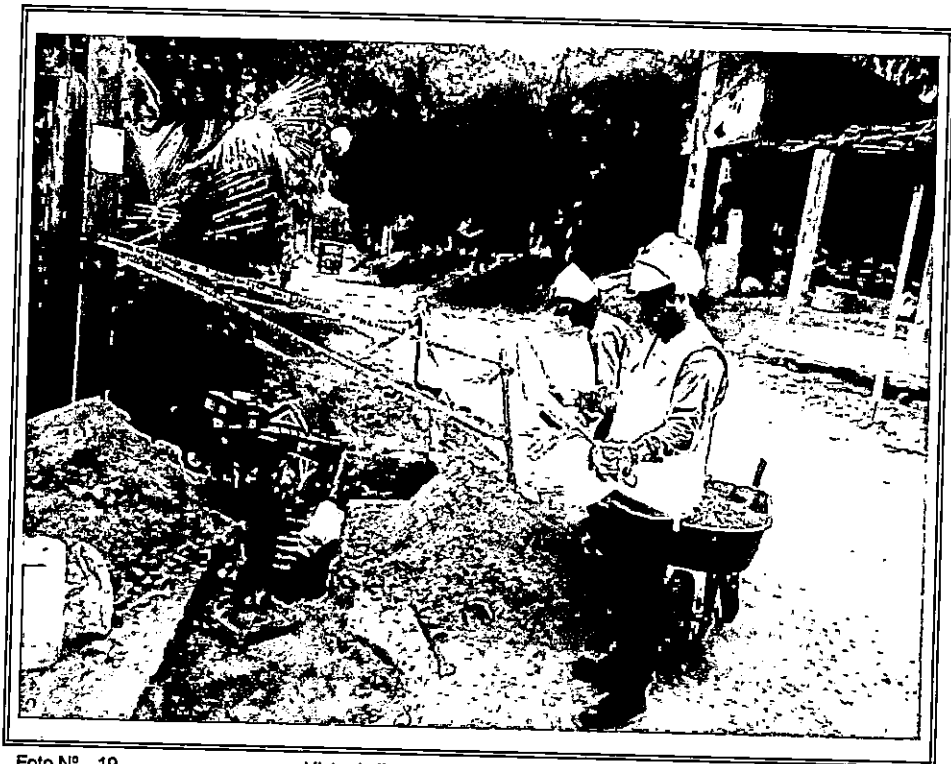
Vista de llenado de la zanja y compactado de la zanja.
