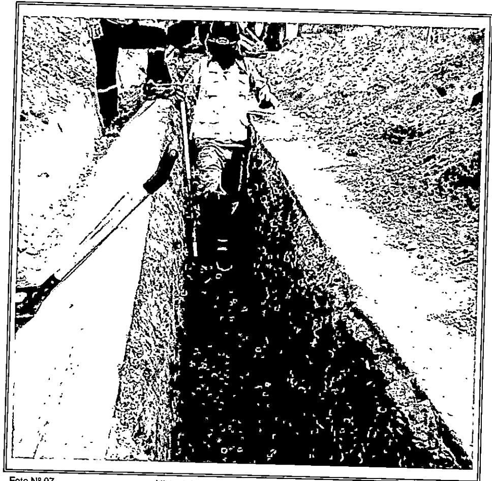
Vista del operario verificando la profundidad de la zanja.
