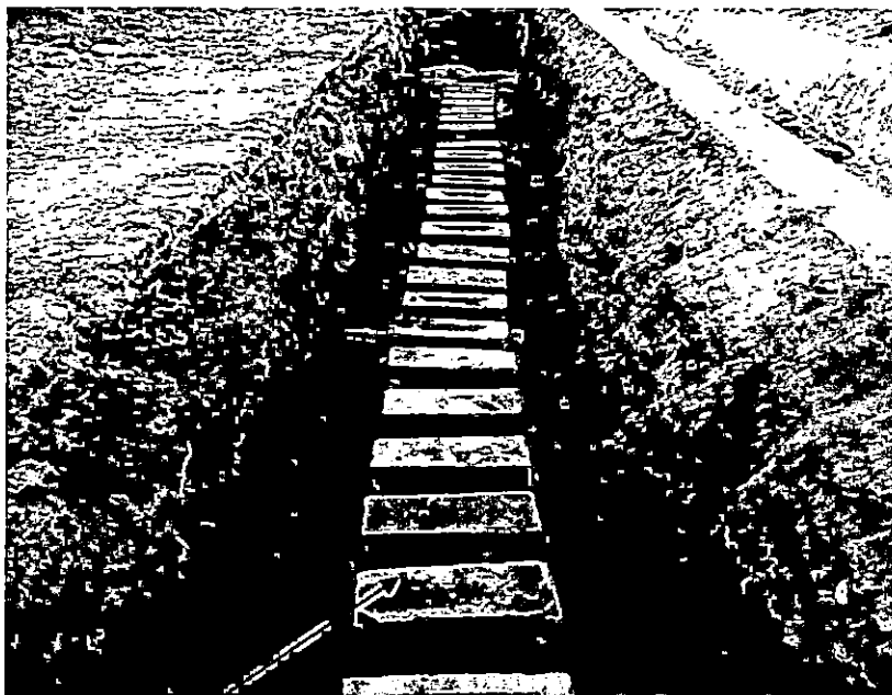
VISTA N° 79: INSTALACION DE LADRILLOS, RELLENO Y COMPACTACION DE ZANJAS CON MATERIAL PROPIO Y DE PRESTAMO.
