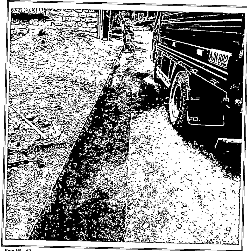
Vista de compactado del relleno de la zanja.
