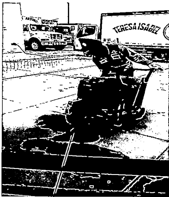
VISTA N° 13: CORTE DE LOSA DE CONCRETO - TRAMO RED SUBTERRANEA EN INTERIOR DEL DPA.
